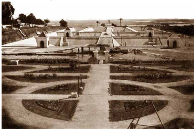
Figura 14: Hidráulica Guaibense em 1890. Obras de construção dos tanques da Hidráulica Guaibense, 1890
