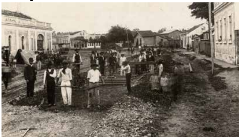
Figura 16: Obra da abertura da Rua 24 de Outubro, 1907
