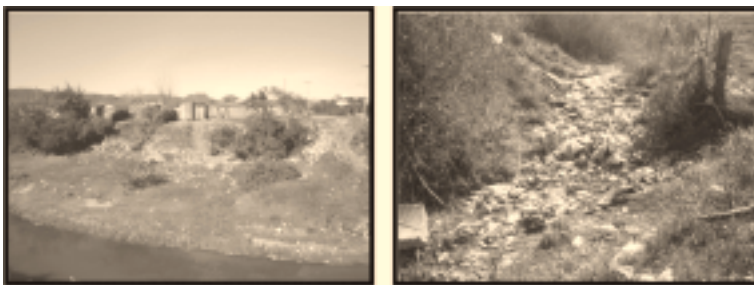
Figuras 3 e 4: Arroio Cadena e lixo espalhado na margem e no curso d'água. Registro Fotográfico: Grupos Detonação e DDN.
