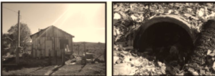
Figuras 5 e 6: Moradias do KM 2 e lixo jogado nos canos de esgoto. Registro Fotográfico: Grupos Fuzarka e Detonação.
